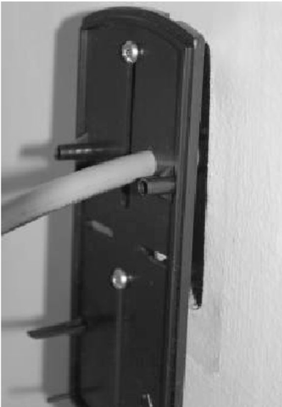
9. ábra > A hátlap felszerelése a falra
